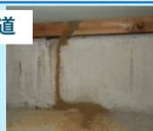
シロアリによる家屋の土台や柱の被害は、家の構造強度が著しく落ちて震災の多い日本では、家の倒壊につながる大きな問題です。
